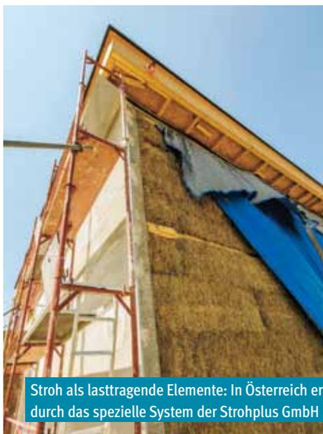
Stroh als lasttragende Elemente: In Österreich erstmals durch das spezielle System der Strohplus GmbH möglich.
