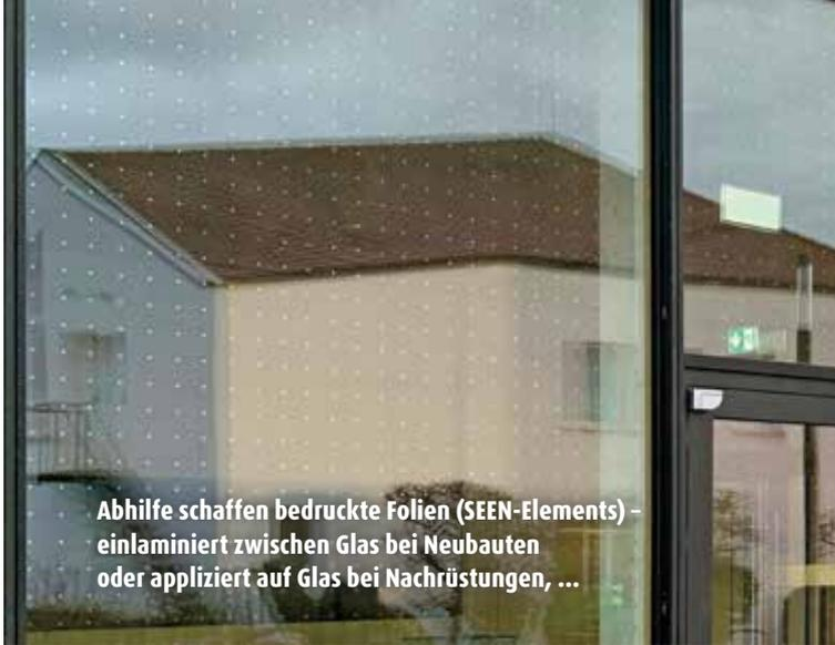
Abhilfe schaffen bedruckte Folien (SEEN-Elements) - einlaminiert zwischen Glas bei Neubauten oder appliziert auf Glas bei Nachrüstungen, ...
