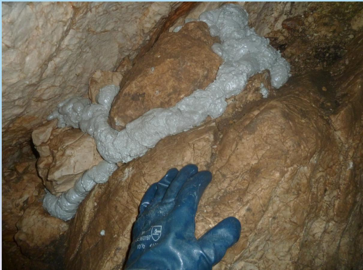
Lose Steine wurden abgeräumt oder wie am Bild sichtbar, mittels PU-Schaum gesichert
