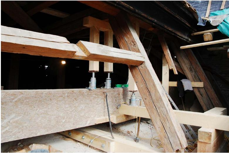
*Hydraulische Stützhilfen sind notwendig, weil ein ganzer Bereich des Dachstuhls aufgrund des hohen Schadensgrades ersetzt werden muss.*
