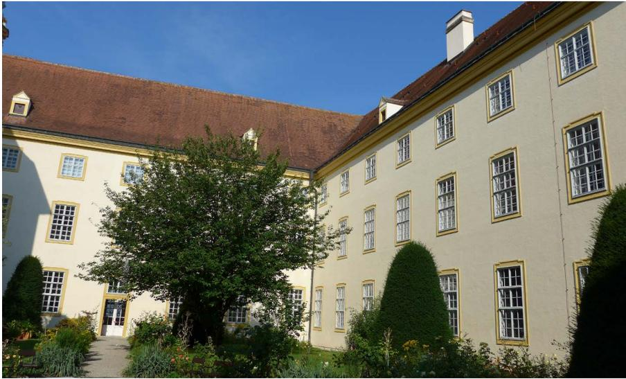
Befund entsprechend im ursprünglich einfarbigen Erscheinungsbild gestrichen. Das aus denkmalfachlicher Sicht positive Ergebnis all dieser Maßnahmen ist die Wiederherstellung des einheitlich geschlossenen Gesamterscheinungsbildes der Fassade. (B.U.-L.)
