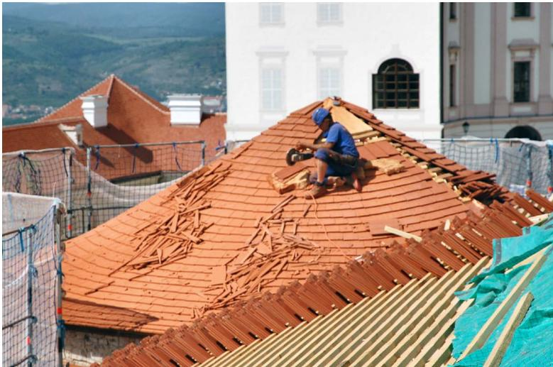
beiden Türme erforderte enorm viel Schneidarbeit, da fast jeder Ziegel an die Rundung angepasst werden musste. Wie im Mittelalter üblich, blieb die Traufe mithilfe eines Staubladens ausgebildet und kam keine Dachrinne zur Ausführung.
