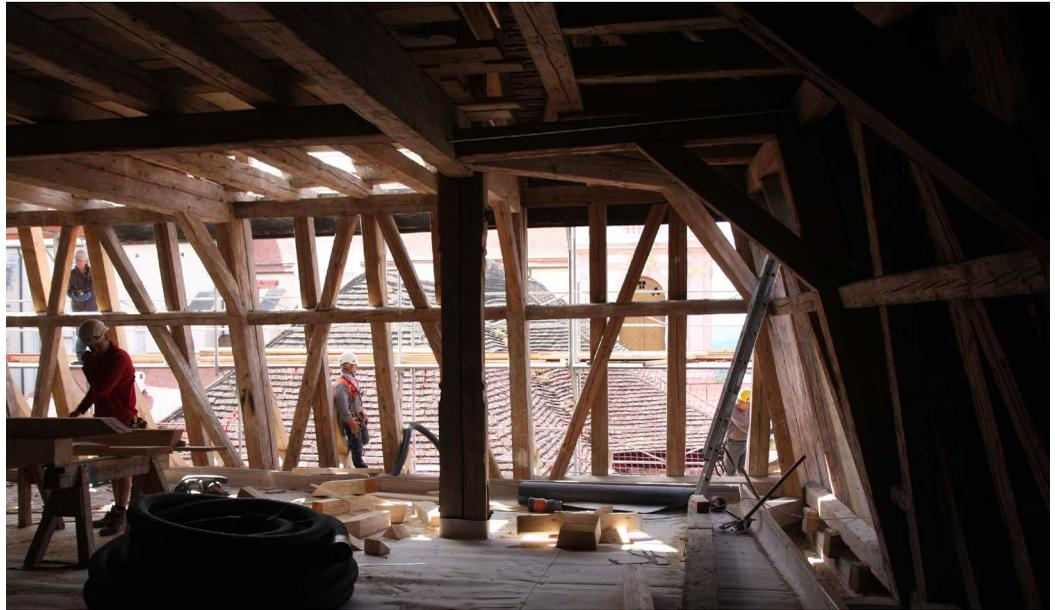
befindliche tierische Schädlinge durch thermische Behandlung abgetötet. Beim Einbau wurde auf eine Holzfeuchte von ca. 15 % geachtet, was in etwa der Ausgleichsfeuchte im eingebauten Zustand über den Jahreszyklus entspricht.
