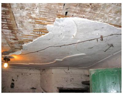
Im Verfall zeigt sich der technische Aufbau einer Putzschnittdecke: Verbretterung, Schilfrohrmatten als Verputzträger, darauf die unterschiedlichen Verputzniveaus sind in einem Haus in Bacharnsdorf zu sehen; wenigstens ist die Stromleitung aufputz verlegt.
