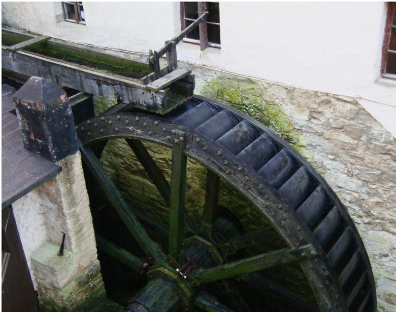
Gemeinsames Merkmal wasser- und windgetriebener, aber auch von vielen der motorisch angetriebenen kleineren, handwerklich arbeitenden Mühlen ist der Einsatz eines zentralen Antriebsaggregats und die Verteilung der Kraft zu einzelnen Maschinen und Anlagen.
