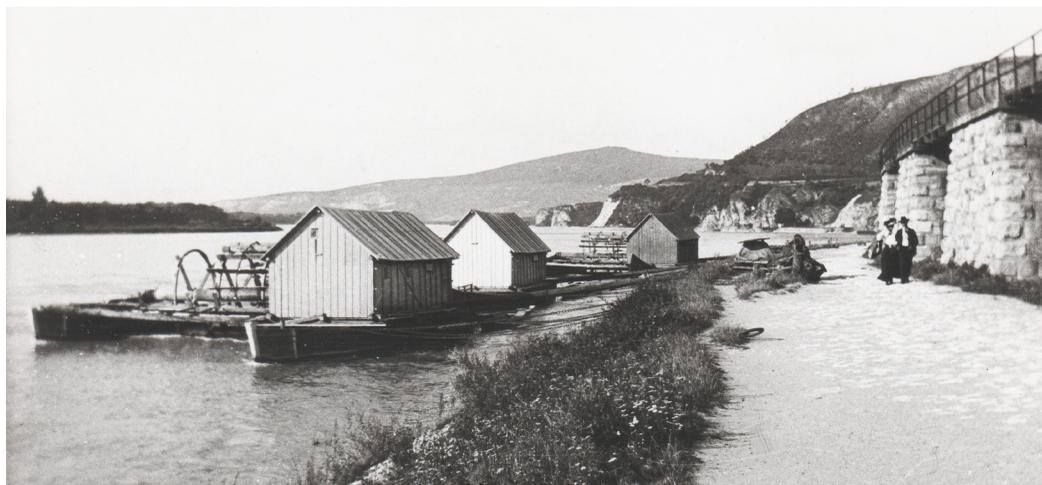
immer Wasser zur Verfügung. Bei Gefahren wie Hochwasser oder Eistreiben konnten Schiffmühlen leicht den Standort wechseln. Auf einer aus einem Lärchen- oder Eichen-Baumstamm gefertigten, bis zu 16 Meter langen Achse waren vier große Räder aufgefädelt. Diese Mühlradachse wurde als Grindl bezeichnet. Der Durchmesser der Räder betrug vier Meter. Darauf waren die Mühlradschaufeln montiert. Je nach Fließgeschwindigkeit lief das Wasserrad gemächlich mit vier bis sechs Umdrehungen pro Minute.
