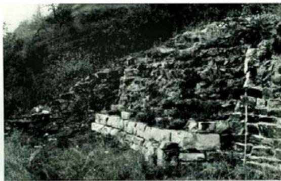
*Imbach, Reste des Rechteckturmes. Die äußere Mauererschale aus Kleinquadermauerwerk, die Mauerfüllungen aus kleinen Bruchsteinen lagig, z.T. als opus spicatum, erstellt.*
