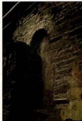
*Horn, Pfarrkirche St. Stephan, Fenster der Langhaus-Südwand (Außenansicht nach Freilegung, 1980). Analoge Struktur zur Westwand, jedoch sorgfältiger zugerichtete Mauersteine. Fensterbogen kleinteilig aus Keilsteinen gemauert, das Gewölbe z. T. aus Mauersteinen z. T. aus Orthostaten gebildet. Sekundäres Fugennetz (=Kellenstrich).*
