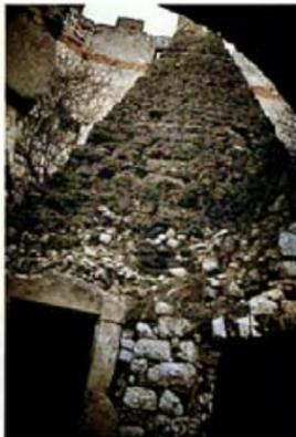
*Burgruine Starhemberg, NÖ. Südfassade des Küchentrakts. Das Portal (links) in Werksteintechnik, das Fenster (rechts) in Bruchstein, der Mauerpfiler dazwischen in ausgebildeter »Netzmauerertechnik«. Die Schornsteinspyramide aus Kalktuff in Quaderertechnik.*
