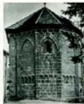
*Tullner Karner, Ansicht von Westen, Zustand während Konservierung (Mittelachse und Sockelzone sind noch in Arbeit, das Platzniveau ist bereits angehoben)*
