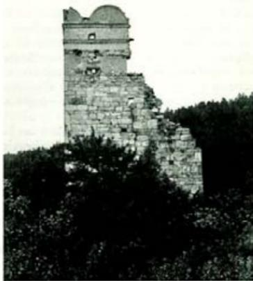
*Rappottenstein, Burg mit polygonalem Bering und noch wenig monumentalem Bergfried; die Burghölzle in Randlage. Schichtmauerwerk mit zonalem Strukturwechsel und gereiht eingelassenen Großquadern; gegen Mitte des 12. Jhdts.*
