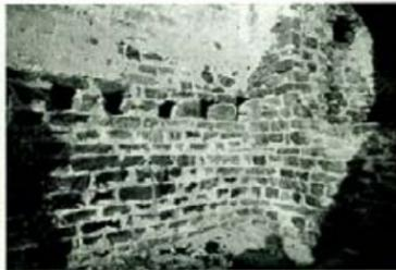
*Zwettl, Stift, sogenannter unterer Einstützenraum. Charakteristisches Schichtmauerwerk gegen Mitte des 12. Jhdts. mit voll ausgeprägtem zonalen Strukturwechsel in Weiterbildung (ähnlich z.B. in: Droßl, Schloßkapelle; Streitwiesen, Bergefried; Rappartenstein, Ringmauer der Burg; Strögen, Filialkirche, Langhaus; Buchberg am Kamp, Burgkapelle; Krumau am Kamp, Bering; u.a.m.).*
