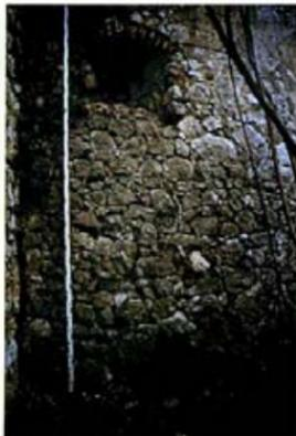
*Burgruine Starhemberg, NÖ. Östliches Rondell des »Waffenplatzes«. Das spätmittelalterlich-frühneuzeitliche Mauerwerk zeigt in seiner Struktur den Übergang vom Schichtmauerwerk zum »Netzmauerwerk« mit Zwickelsteinen in den Stoß- und Lagerfugen. Die Fensterbögen sind nicht mehr in Bruchsteintechnik ausgeführt.*
