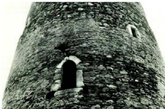
*Hartenstein: Rundturm der Vorburg, ursprünglich freistehend. Zwei unterschiedliche Mauerstrukturen: bis zur Kämpferhöhe die Struktur des späten 13. Jhdts., mit partiell zusammengefügten, annähernd gleich hohen Lagen und nicht durchlaufenden dünnplattigen Abgleichungen, oberhalb ein kleinteiliges, z.T. aus dünnen Platten gebildetes Mauerwerk. 1. Hälfte 14. Jhd., mit partiellen Lagenabgleichungen und Auswickelungen (Ansätze zum Zwickelmauerwerk).*
