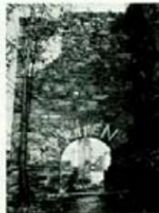
*Schauenstein, Tor zur Hauptburg (Außenseite). Bruchsteinmauerwerk 2. Hälfte des 13. Jhdts. Struktur analog der des Bering, jedoch schon ohne strenge Bindung an die Einzellage durch partielles Zusammenfassen von 2-3 Lagen zu abgegliederten Mauerkompartimenten (Ausbildung von Arbeitshöhen).*
