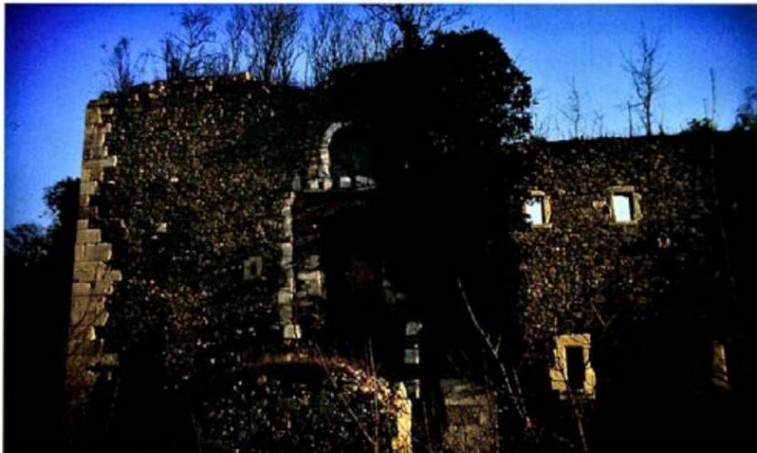
*Scharfeneck beim Mannersdorf, Torbau der Hauptburg, 2. Hälfte 15. Jhd. Sorgfältig ausgeführt in Fläche gearbeitetes Zwickelmauerwerk mit abgeglichenen Arbeitshöhen. Das Einbetten großer Mauersteine, wie*
