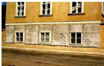
*Sanierputze sollen mit horizontalem Fassadenelement abschließen*
