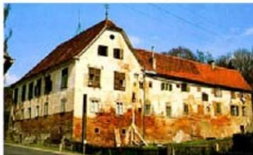
*Langzeitverhalten des Versuchs einer Sanierung nur mit Sanierputz: Zustand 1979 vorher*
