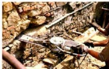
*Horizontalisierung, Schnitt mit Kettensäge*
