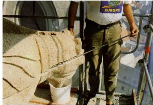
*Verstärkungen der auskragenden Teile mittels Carbonstäben*
