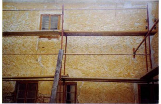
*Ostfassade nach der Verputzergänzung und Färbelung. Der Eingangsbereich gehört bereits zum nächsten Bauabschnitt. Farbunterschiede im Sockelbereich durch Restfeuchtigkeit und Restversalzung im Altputz sind bei der Verwendung von Kalkfarbe kaum vermeidbar.*
