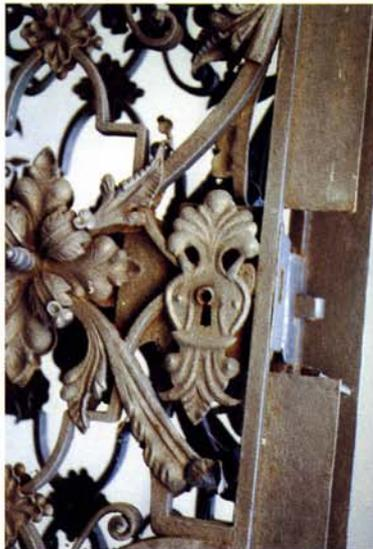
Unterrostung schlechte Haftung, Craquelierung und Abplatzungen. Korrosion: unterschiedlich weit fortgeschritten, in Hinterschnidungen und am äußeren Rahmen, an Kontaktstellen zum Stein, besonders starke aktive Rostung. Vernietung des Stehers lose.
