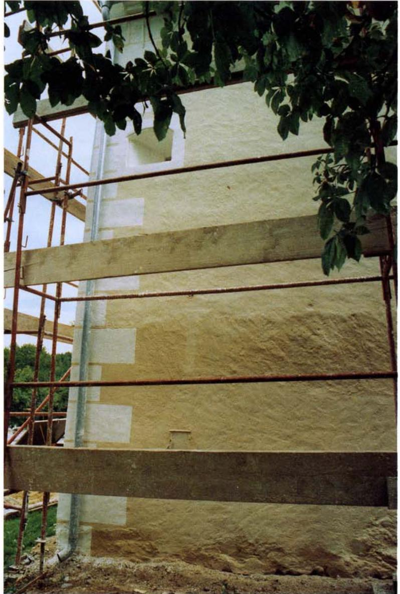
*Westfassade. Der Neuputz wird im Sockelbereich immer dünner und läuft unten zu einer Tünche aus.*
