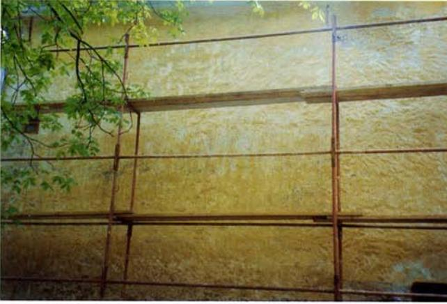
*Die West-Fassade mit dem Originalverputz aus dem 17. Jb. und wunderschöner Kellenstruktur, mit zahlreichen Kalktünchen und sehr gutem Zustand. Auch hier die Sockelzone bereits abgeschlagen.*
