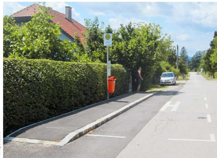
Auch kleinste Haltestellen sind gemäß dem Stand der Technik mit einer Fahrgastaufstellfläche zu errichten.
