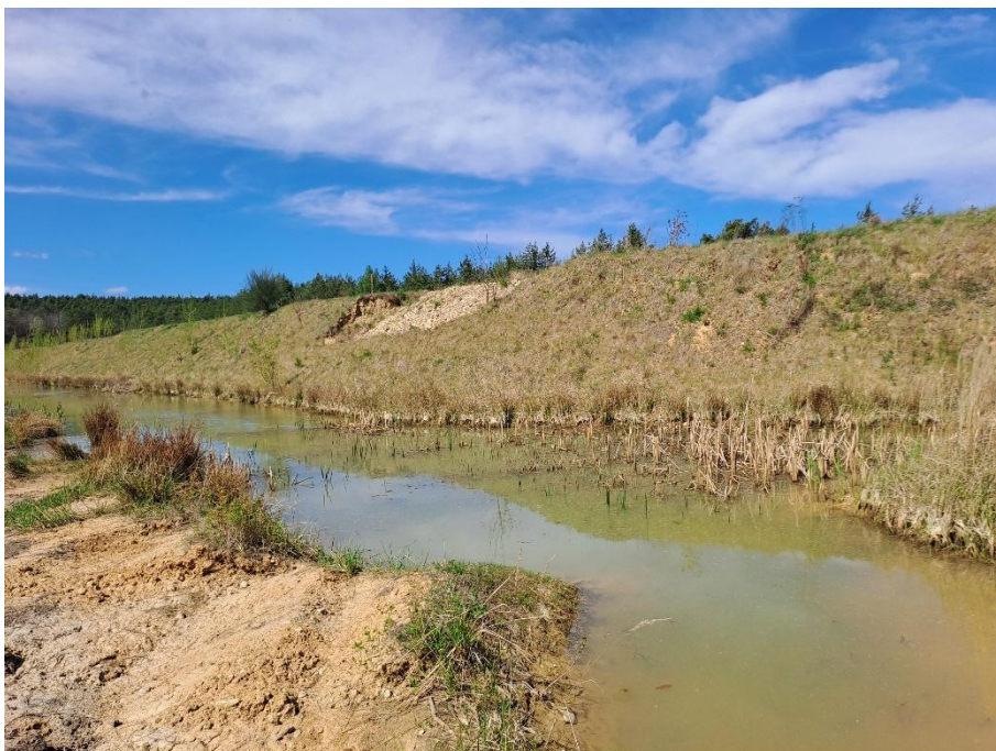
Abbildung 4: Retentionsbecken mit Feuchtvegetation (Quelle: eigene Aufnahme; Begehung 16.04.2025)
