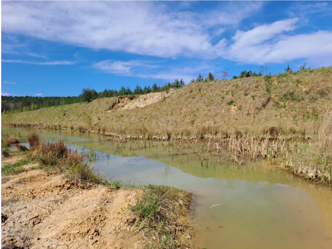
Abbildung 16: Retentionsbecken mit Feuchtvegetation (Quelle: eigene Aufnahme, Begehung 16.04.2025)
