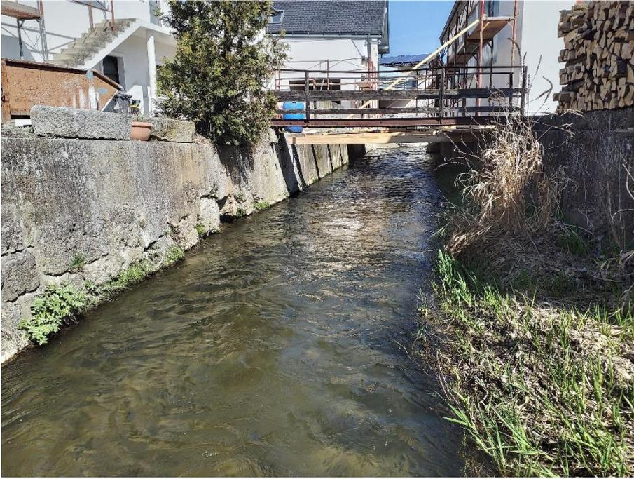
Abb. 28 *Hart verbauter Erlabach durch St. Pantaleon.*
