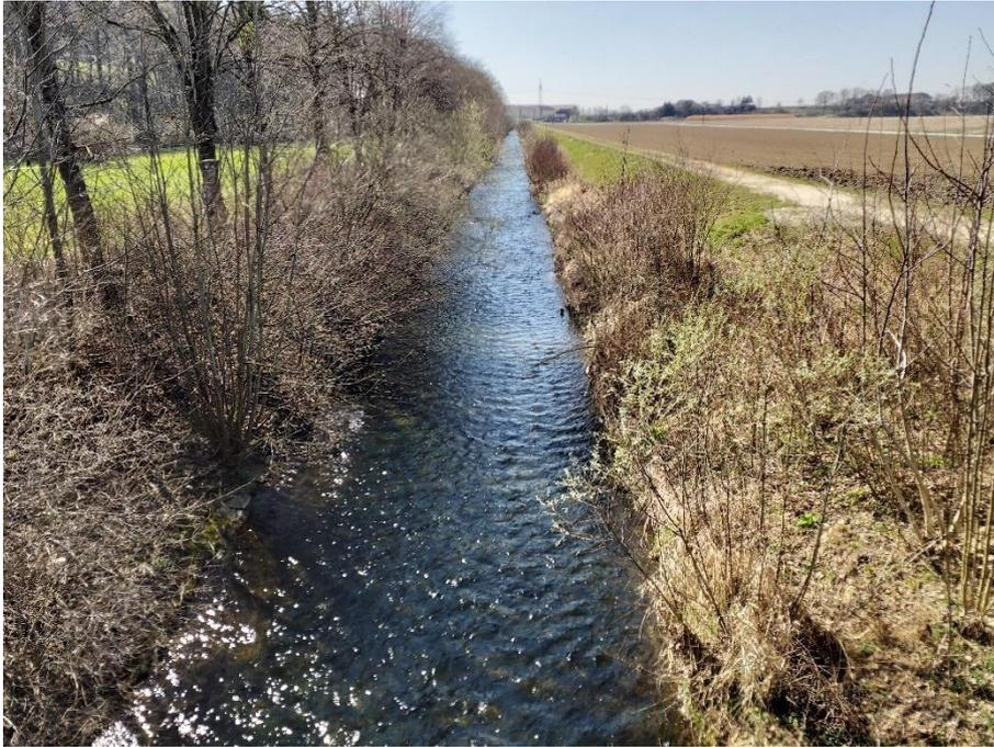
*Abb. 26 Verbautes Bachbett des Erlabaches zwischen dem Teilungsbauwerk in St. Pantaleon und dem Kraftwerk Weindl.*
