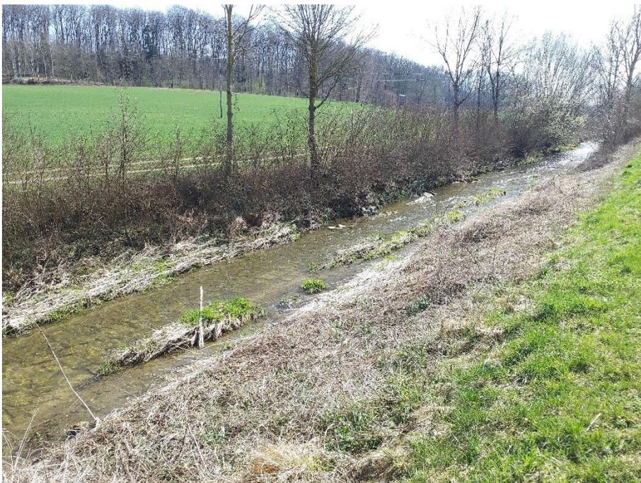
*Abb. 27 Reguliertes Profil der Restwasserstrecke des KW Weindl.*
