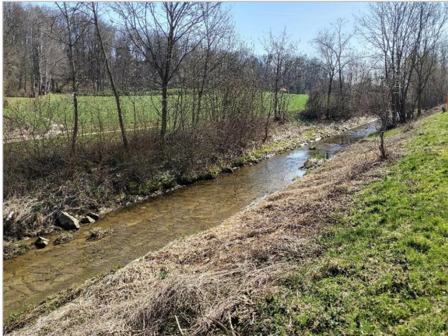
Abb. 62 *Regulierter Abschnitt mit gepflasterter Sohle, der für viele Fischarten keinerlei Lebensraum bietet.*
