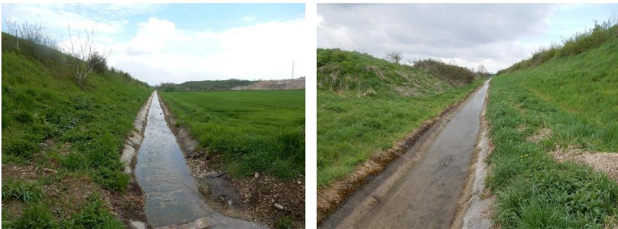
Abb. 51 *In Betonhalbschalen verlegter Remserbach bei Raad parallel zum Oberwasserkanal.*
