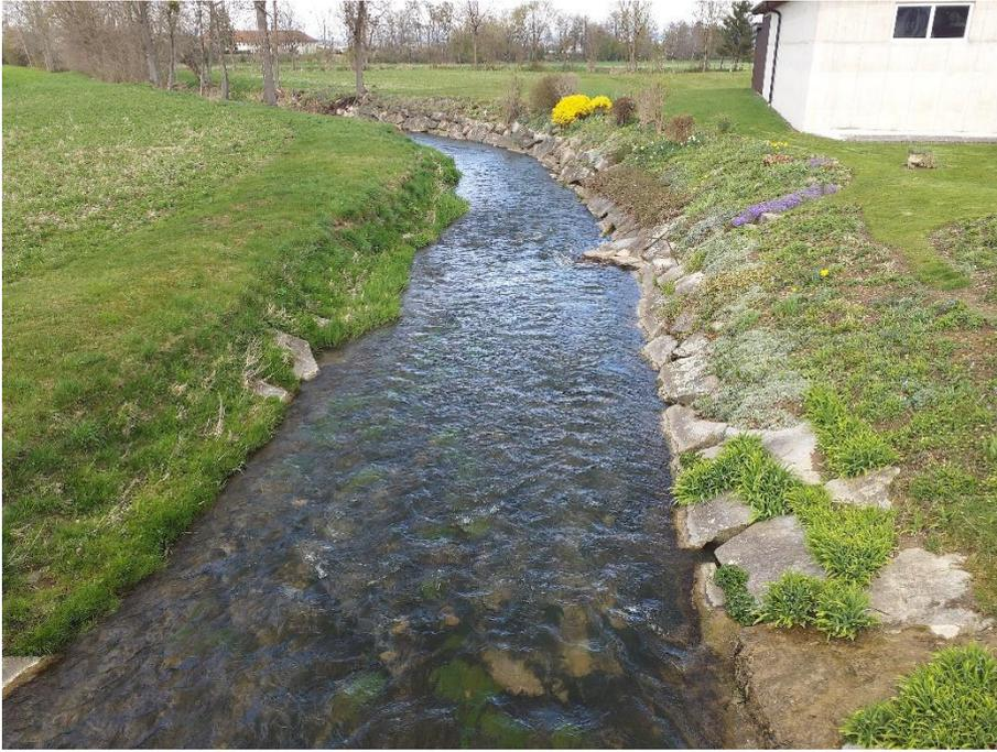
*Abb. 30 Hart verbaute Ufer im Erlabach bei Stögen.*
