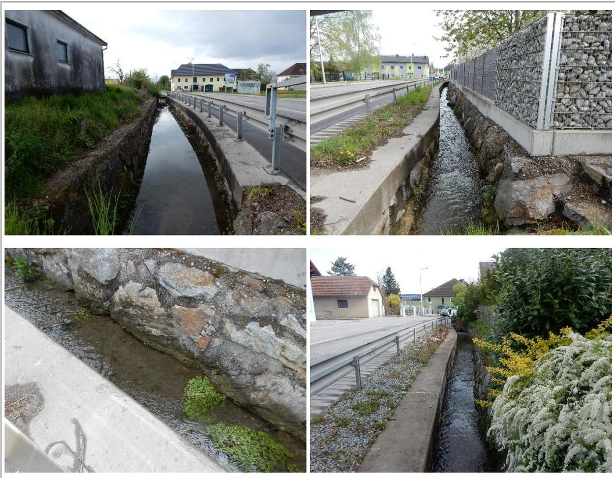
Abb. 49 Hart verbauter Remserbach durch Rems bis zur Verrohrung.
