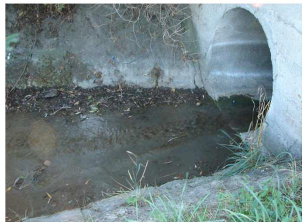
Abbildung 32. Undichtheit in der Überleitung vom Wiener Neustädter Kanal zum Badener Mühlbach (26.08.2015).
