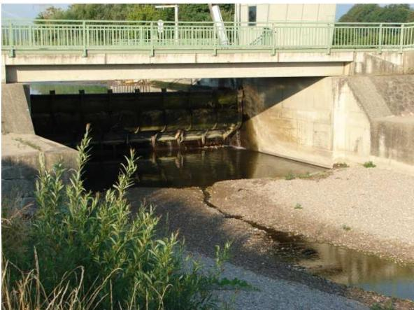
Abbildung 35. Totalausleitung der Triesting Richtung Mödling bei den sog. Kaiserablässen – bis auf Undichtheiten an der Wehranlage (06.08.2015).
