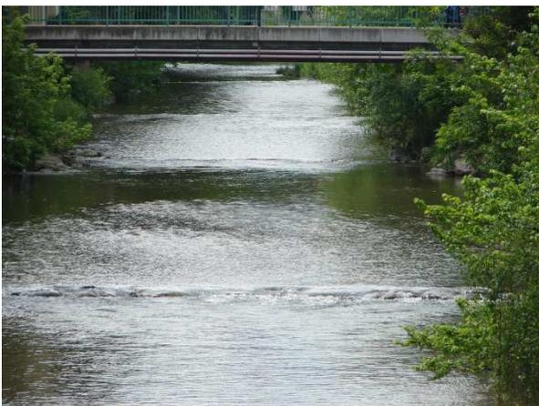
Abbildung 68. Vier Sohlschwellen zwischen Sauerhofbrücke und Pergersteg, direkt unter dem pergersteg und zwischen Perger-Steg und Kaiser-Franz-Josef-Brücke (int.Nr. 03 bis 06).
