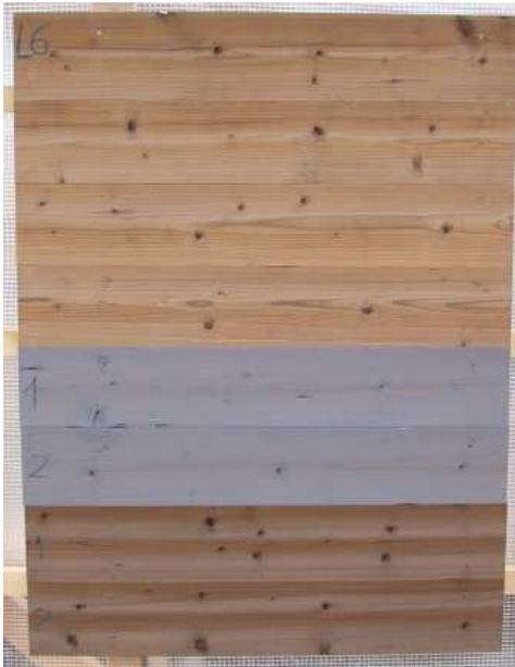
**Abbildung 8g - Fassadenelement 7: liegende Profilbretterschalung**
