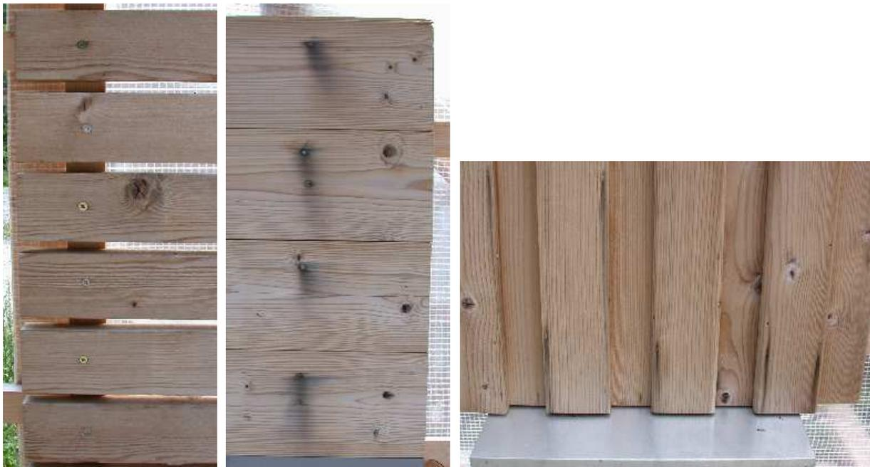
**Abbildung 10 – Auswirkungen (Verfärbungen) verschiedener Verbindungsmittel auf die Oberflächen der Fassade**
