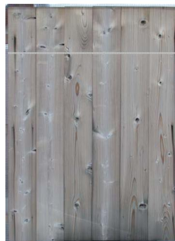
**Abb 128 & 129 - Auswirkungen des Spritzwassers auf den direkt bewitterten Fassadenbereich (oben) und die unterschiedliche Vergrauung im Traufenbereich (unten)**
