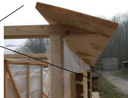
Abb 68 - fertig gestellte Fassadenelemente mit kleinem Vordach
