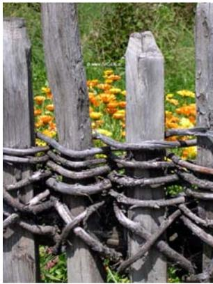
Abb 2 - Befestigung der Zaunlatten mittels hitzebehandelter Zweige
