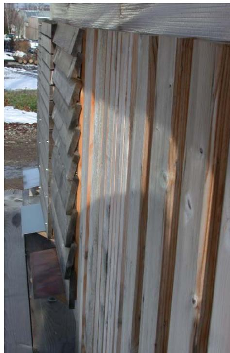
Abb 124 - Blick parallel zu den thermisch modifizierten Lamellen der einzelnen Fassadenelement nach 12 Monaten Bewitterung
