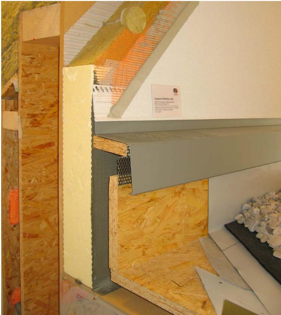
Abbildung: Anschluss Wand-Flachdach (Foto: Ulla Ertl)
