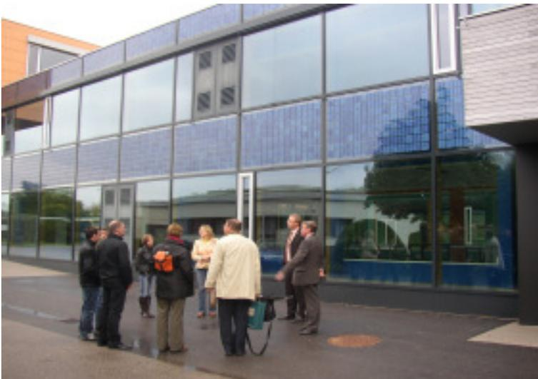
Abb. 23: Die neue „Solar“-Fassade mit Photovoltaik-Elementen am Mitteltrakt des auf Passivhausqualität sanierten Schulkomplexes.
