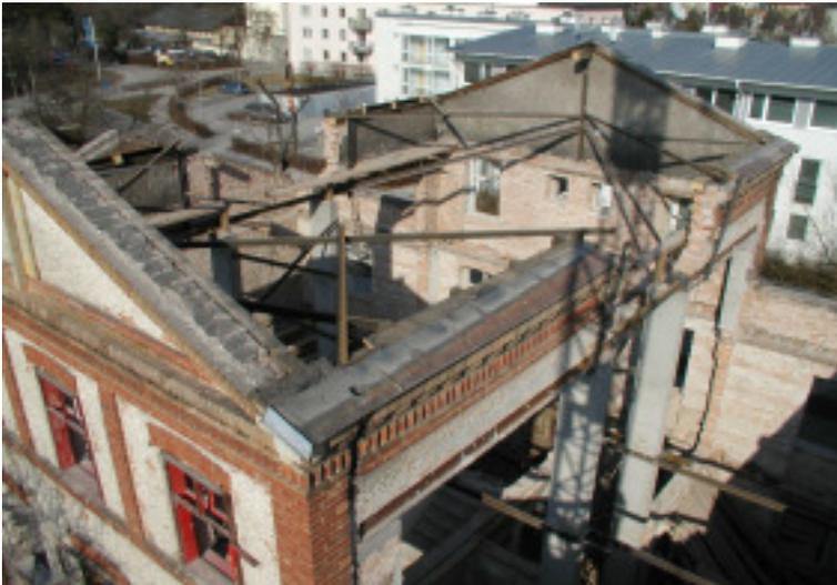
Abb. 19: Entkernter Gebäudetrakt mit der erhaltenen, unter Denkmalschutz stehenden Fassade.
