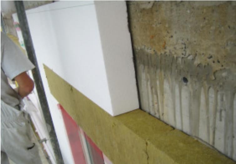
Abb. 24: Einbau eines Brandriegels aus Steinwolle in eine Vollwärmeschutzfassade.
