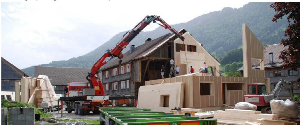
**Abbildung 37: Montage vorgefertigter Holz-Stroh-Wandelemente (DI Ingomar Reumiller)**
