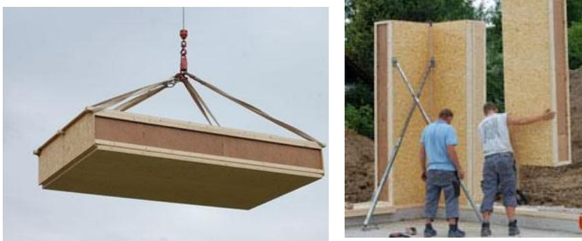
**Abbildung 17: Anlieferung eines Deckenelements(ii), Montage von Wandelementen (re) (Kreativer Holzbau GmbH)**
