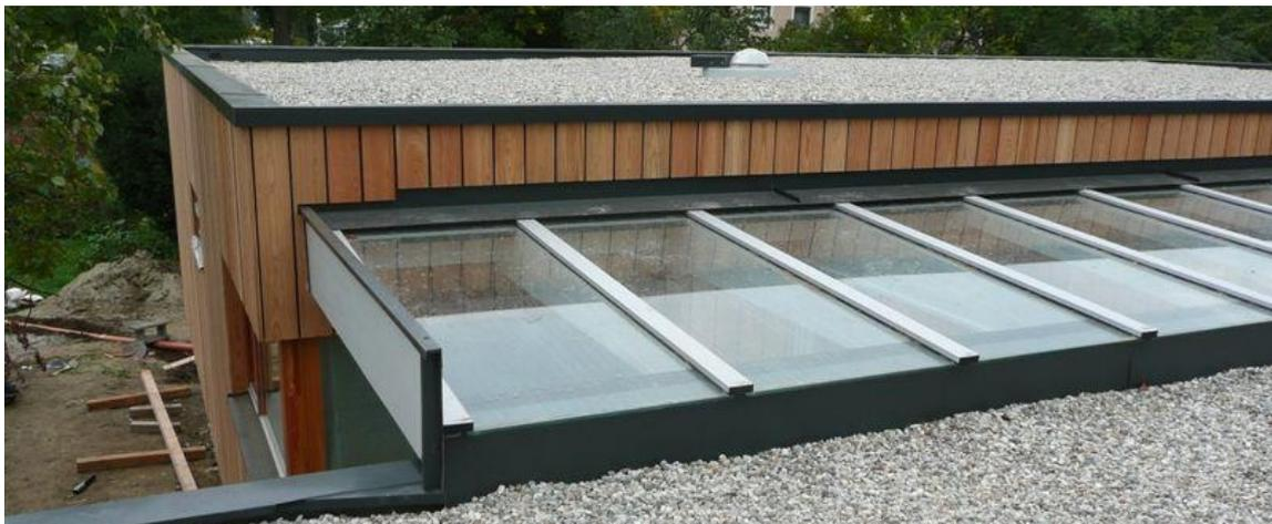
**Abbildung 19: Flachdach mit Kiesschüttung, hinterlüftete Holzfassade mit Nut-Feder-Schalung (Kreativer Holzbau GmbH)**
