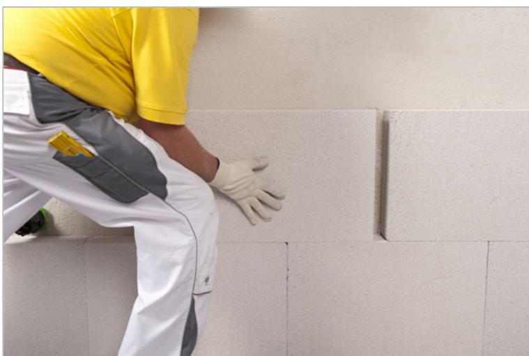
**Abbildung 44: Multipor Dämmplatten (Xella, o.J.)**
