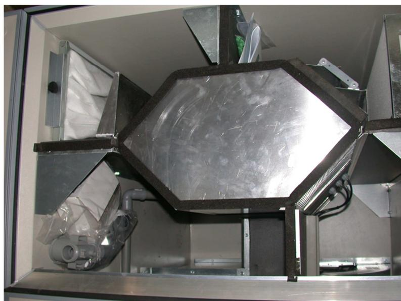
Abbildung 6: Wärmerückgewinnungseinheit des Lüftungsgerätes [AEE INTEC]
