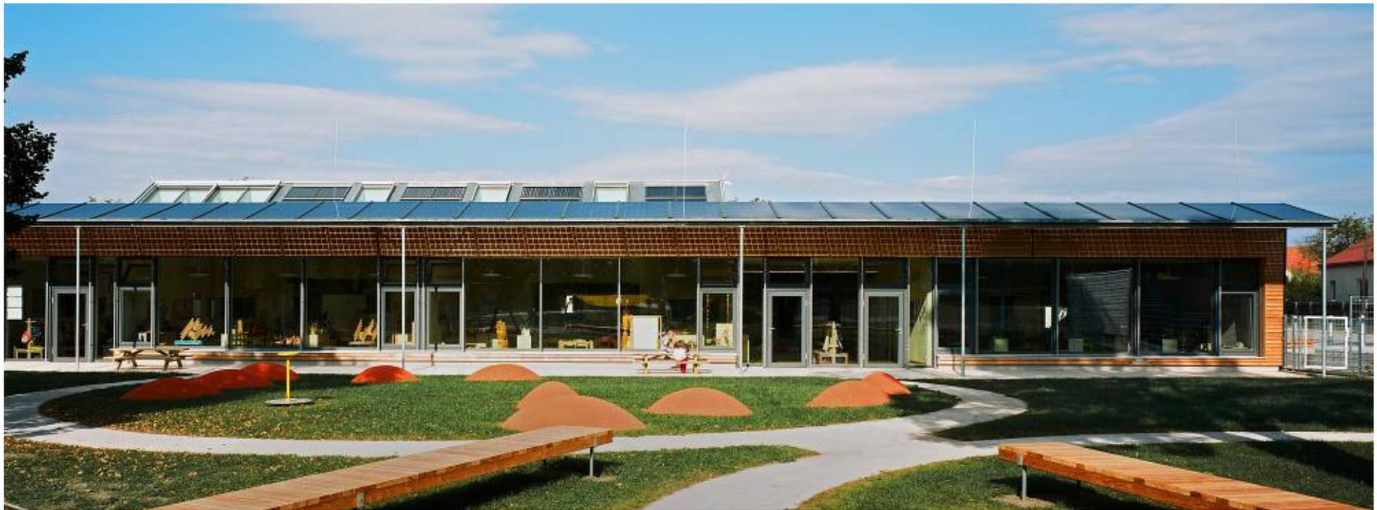
Baubeginn: 05/ 2008, Fertigstellung: 08/ 2009, Konstruktionssystem: Brettsperrholz, Statistik: 735m<sup>2</sup> Nutzfläche, Energiekonzept: Passivhaus, Passive Solarnutzung, Therm.Solarkollektoren (30m<sup>2</sup>), Wärmepumpe, PV: 110m<sup>2</sup> Architekt und Generalplaner: Architekturbüro Reinberg ZTGesmbH.
